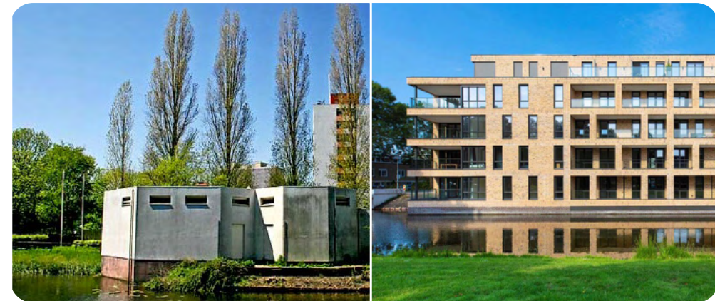
De Synagoge Amstelveen gesloopt (2017) voor woningbouw
